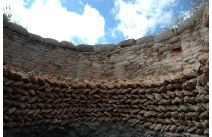
En cada "reor" las piedras se inclinan hacia la izquierda o la derecha alternativamente.
