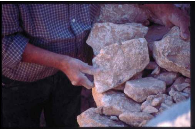
Seleccionando las piedras para ser colocadas
