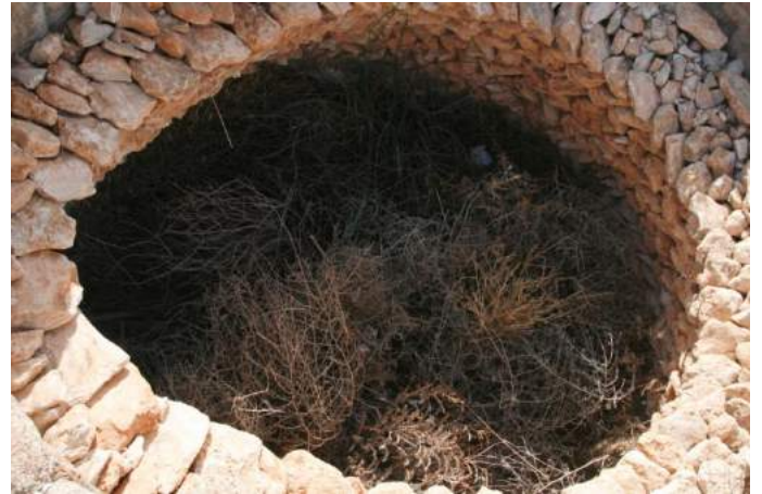
En cada "reor" la hilera se saca un poco hacia el centro, con objeto de ir cerrando la bóveda. Es "tirar el horno"
