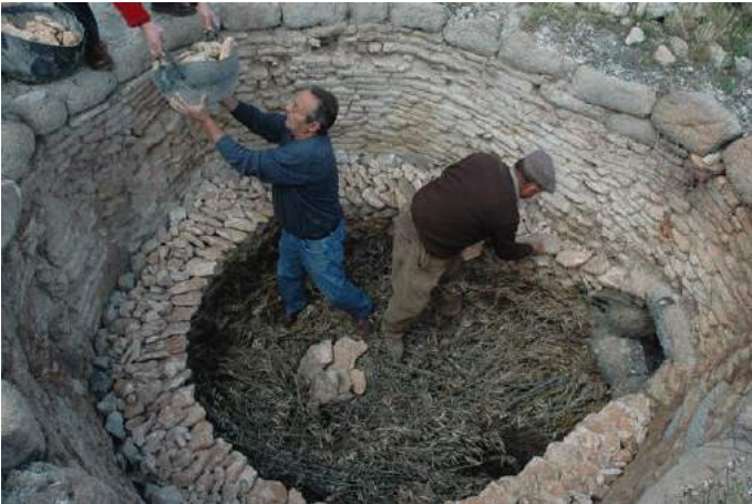
Los caleros subidos sobre la "chamá" (leña) echan "reores" (colocan filas de piedras)
