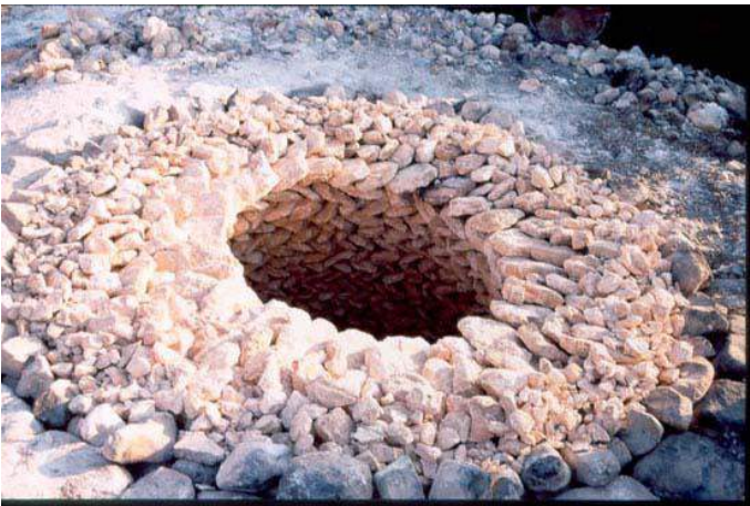
El horno está lleno, falta cerrarlo
