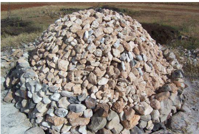
La cúpula se recubre con cantos (cuarcita) para aprovechar el calor
