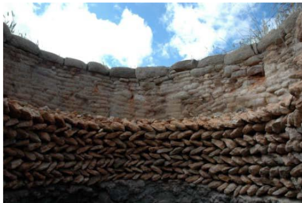
Foto 7.- Horno a medio montar.
