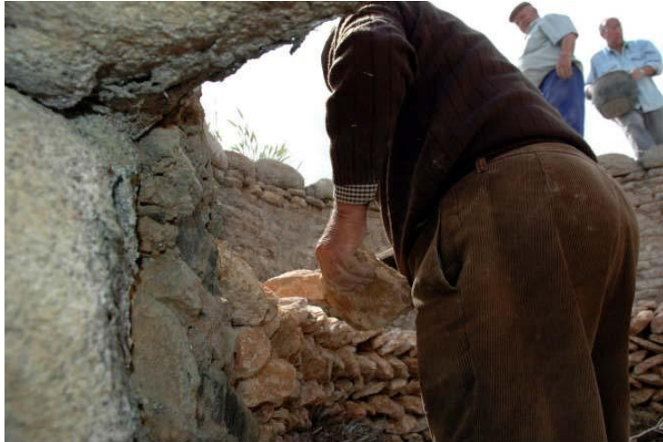
Foto 6.- Colocación de “armaeras”.
